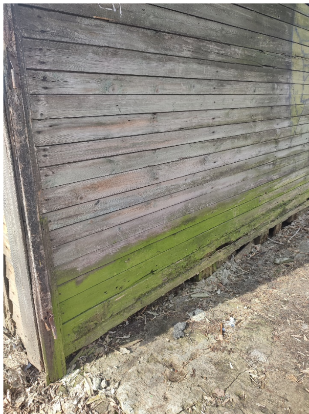
Точка фотофиксации №13. Следы биопоражений (северный фасад)
